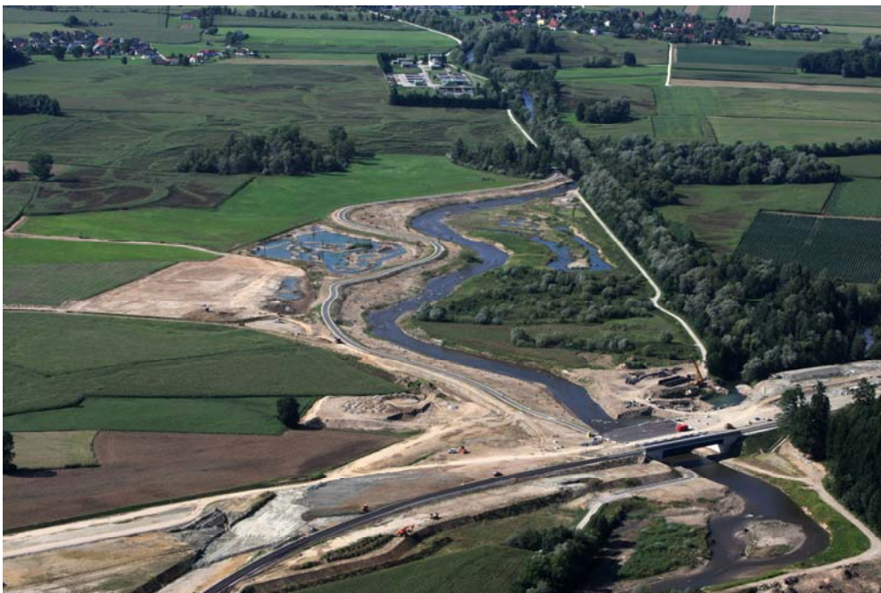
Abb. 5: Neue Lavant bei St. Paul (Foto: ÖBB)
